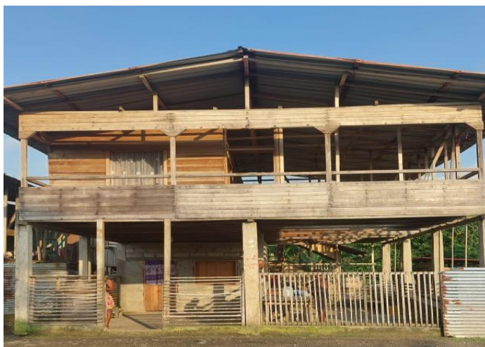
Foto 3: Construção de casa de madeira perto da ponte de Lembá
