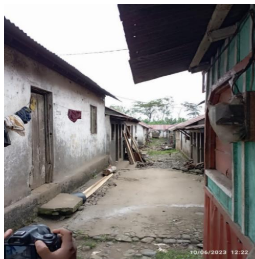
Foto 2 : Construção alvenaria/casa comboio em Brigoma
