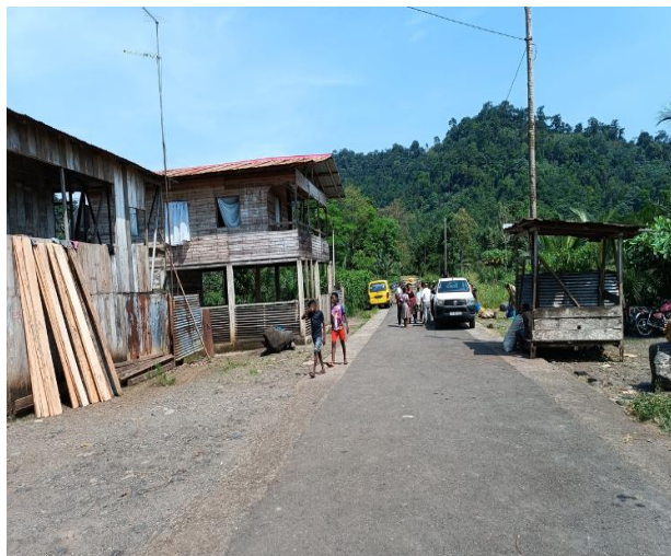
Foto 1 : Construção de casa de madeira perto à ponte de Lembá
