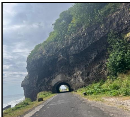
Foto 7 : Tunel de Santa Catarina
